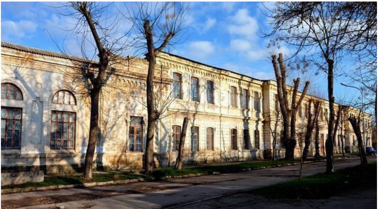
Gymnase Eupatoria pour hommes. Architecte ingénieur civil A.L. Heinrich. Photo : Svetlana Usolzeva
